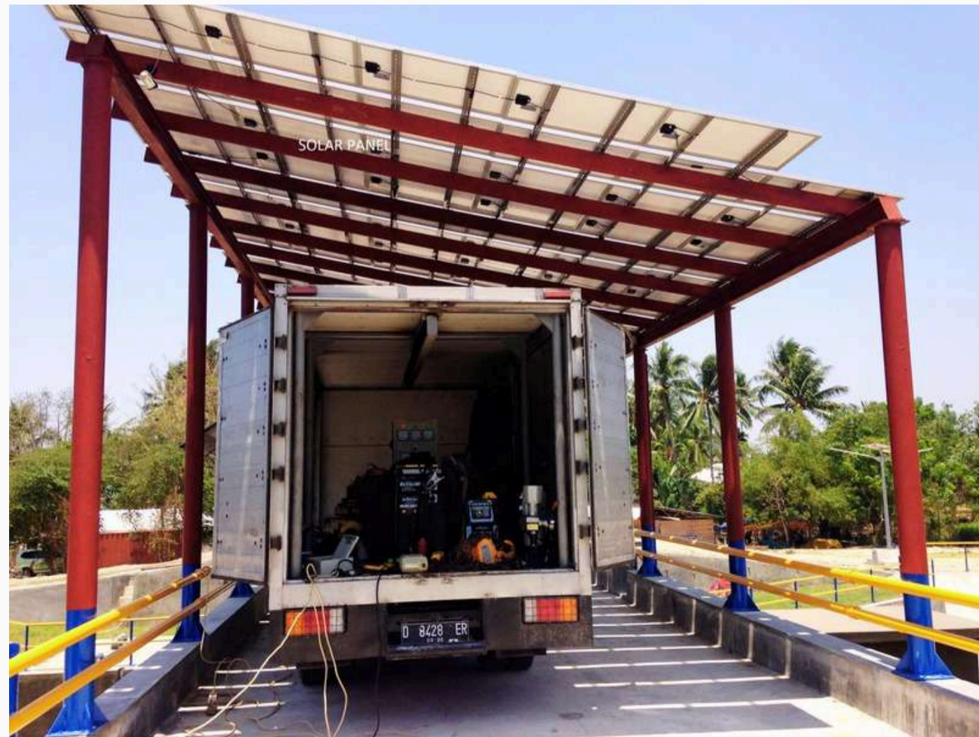
Solar Panel sebagai sumber tenaga listrik AC
